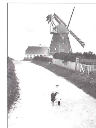
Mellemmølle, der lå på hjørnet af Kronborgvej og Thylandsvej.
