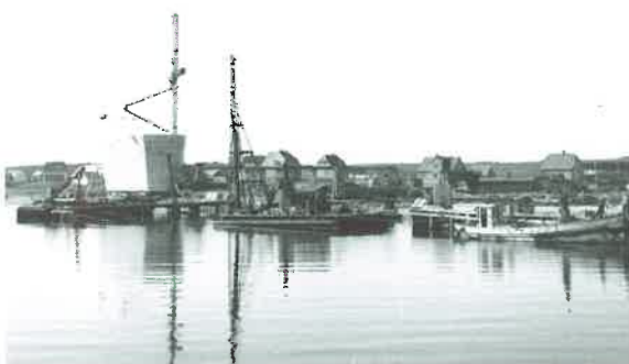
Sænekasserne støbes på bedding.
