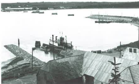
Sænekasserne er på plads. Set fra Mors-siden.
