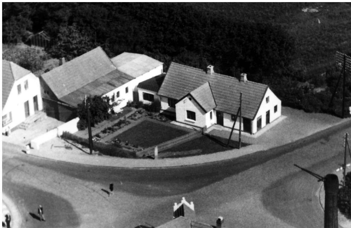
Poul og Anine Graugårds ejendom, som husede maskinstrikkeri og trikotageforretning, 1944. Ejendommen blev revet ned i 1975 og et nyt hus opført af el-installatør Henning Poulsen, Snedsted.
