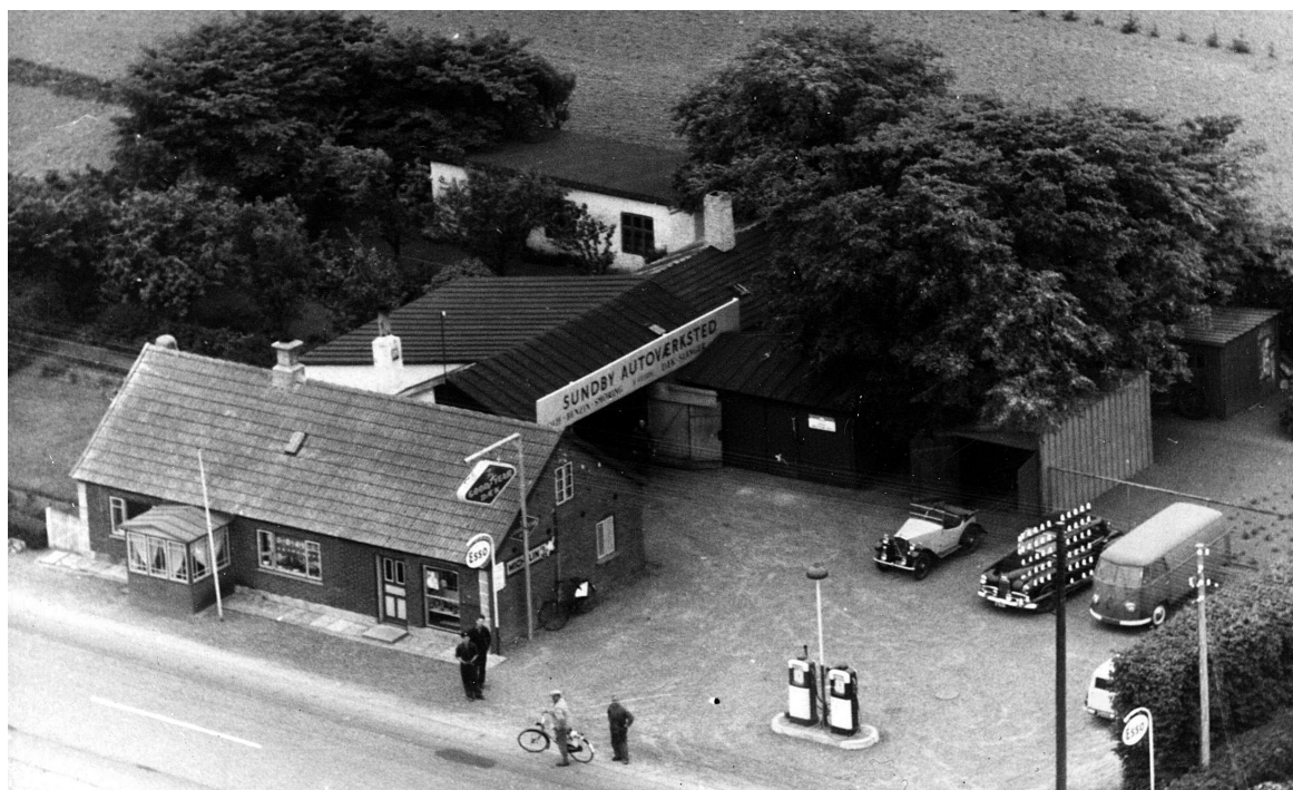
Sundby Autoværksted, Møgelvej 59. Her har tre generationer Kvejborg drevet værksted siden 1930. Billedet er fra slutningen af 1950'erne.
