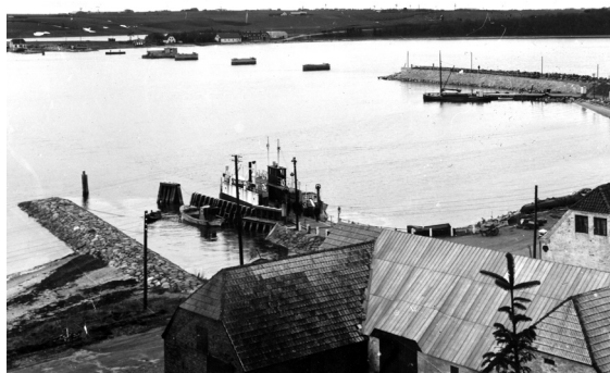
Sænkekasserne er på plads. Set fra Mors-siden.
