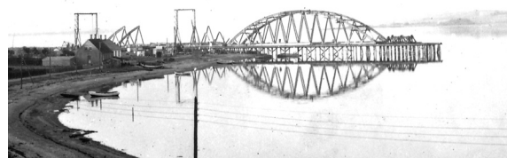
Det første buefag færdigt på Mors-siden.
