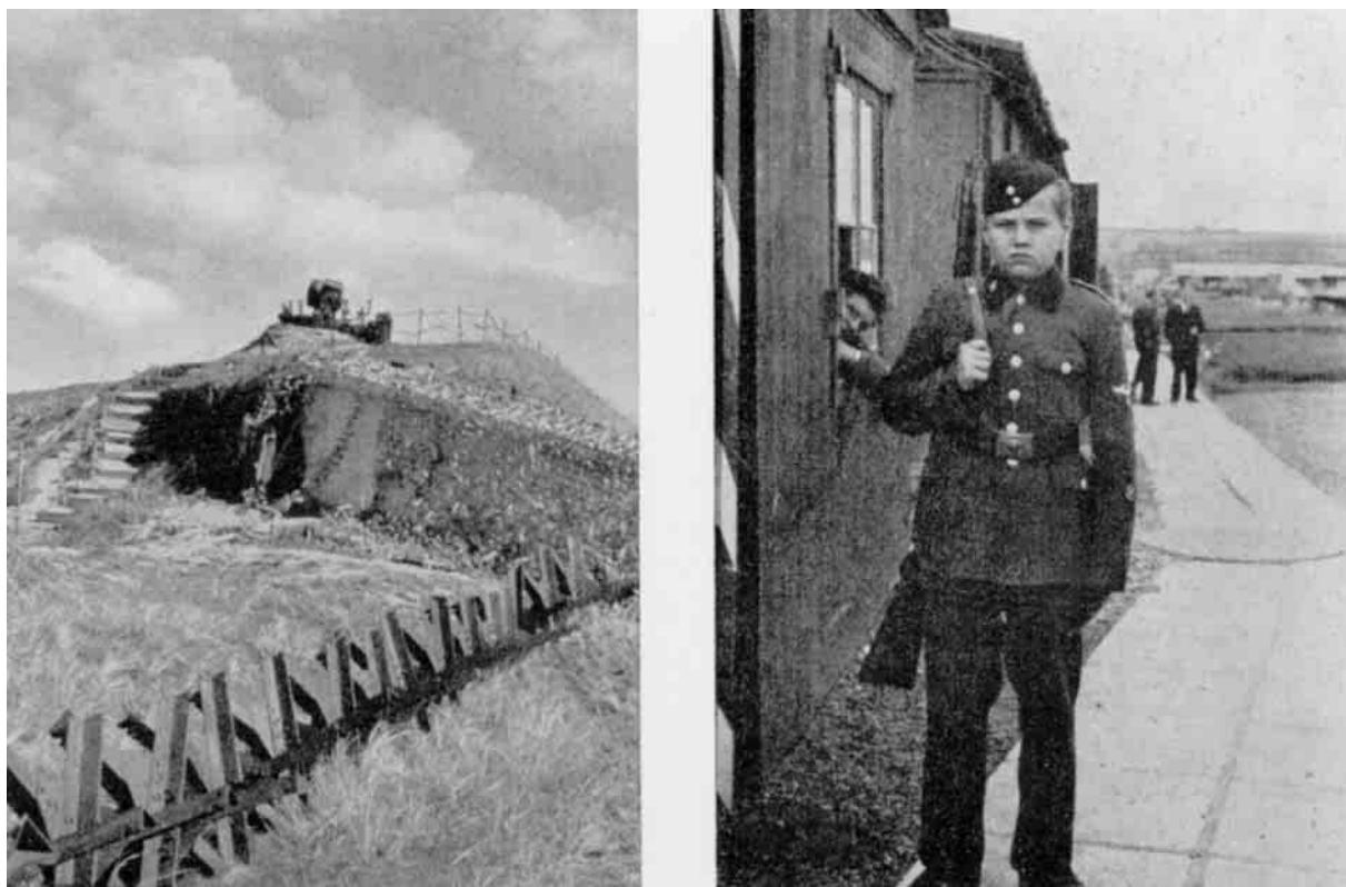
T.v.: Hele Hansted By blev undermineret af Kanonstillinger og Bunkers. Her ses Nedgangen til et af Fæstningsværkerne. Paa Toppen ses en Lyskaster. (Sv. Aa. Kuhl fot.).
