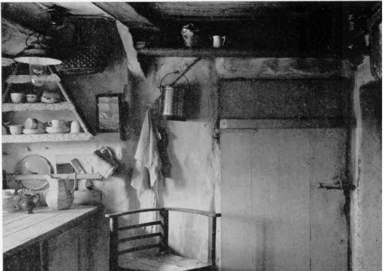
Fig. 15. Køkken i Anders Andersens hus i Agger. Til højre et hjørne af den aabne skorsten. Døren fører ind til dagligstuen. Til venstre herfor ses højremmen i loftet og et skraabaand fra denne ned til et højrebsben. Yderst til venstre anes udskudstagets skraa underside. H. Zangenberg fot.
