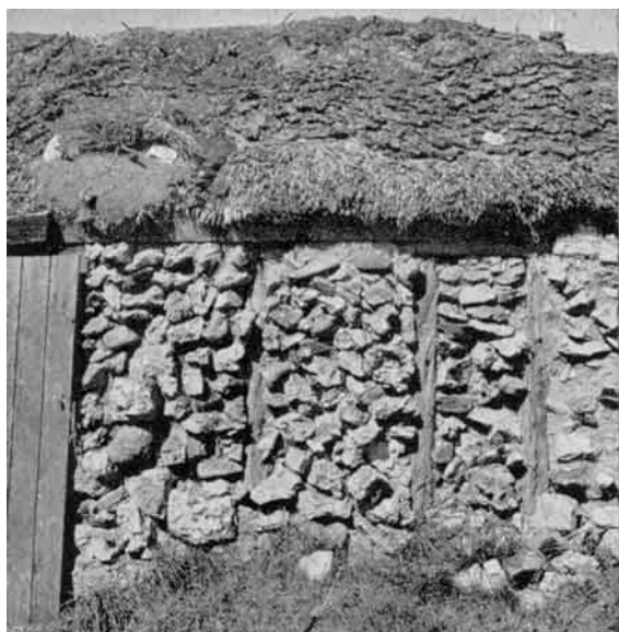
Fig. 19. Hans Andersen Bødkers hus paa Kronens hede ved Klitmøller. Udsnit af den simple ydervæg, der er bygget af flintblokke lagt op i ler mellem spinkle lodrette stolper. H. E. E. fot.
