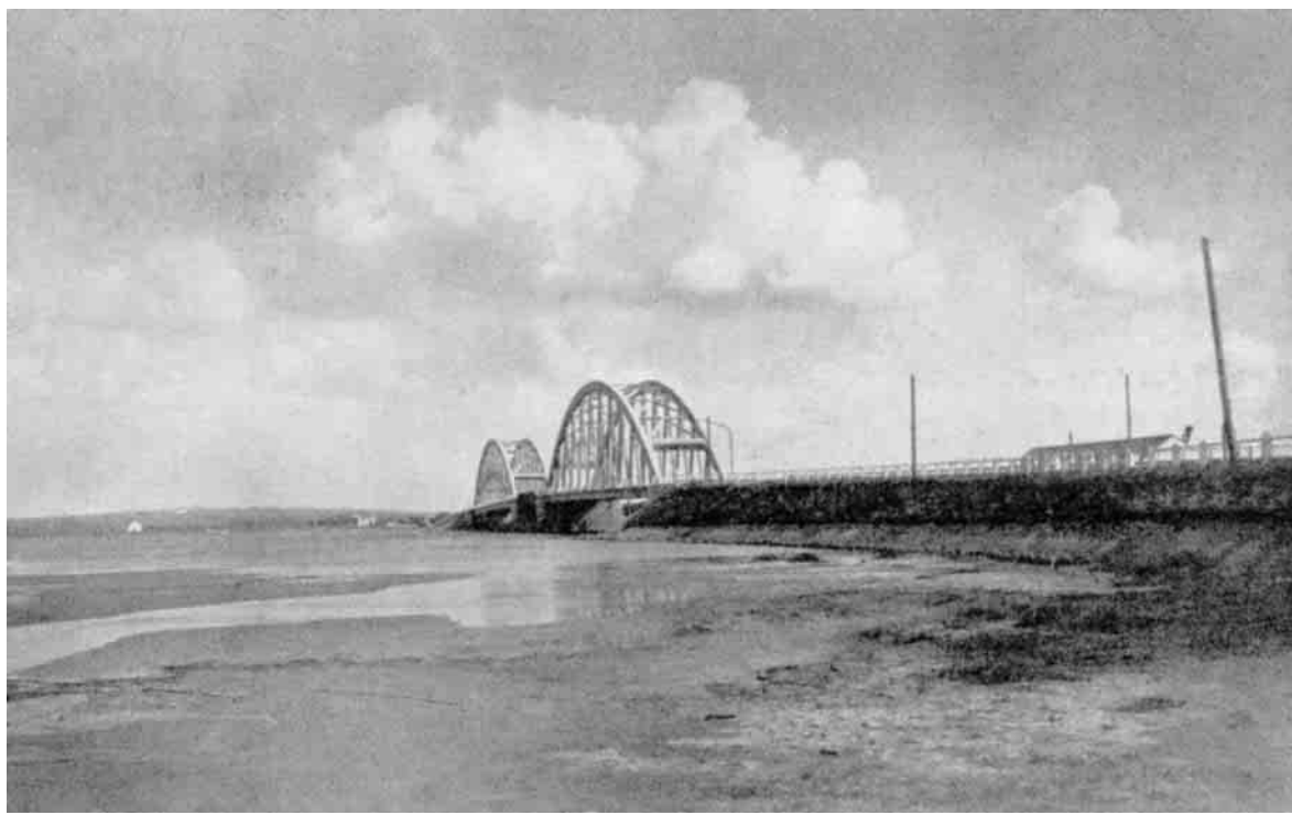
Aggersundbroen bestaar af lange Dæmninger over lavvandede Arealer og en forholdsvis kort Bro med to Brofag og Gennemsejlingsaabning. Broen ses her fra Sydsiden. (Aksel Bjerre fot.)
