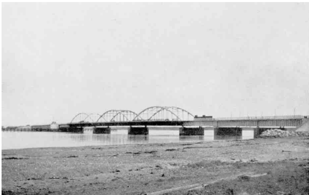
Oddesundbroen, der opførtes i Aarene 1934-38 ses her fra Sydvest. Gennemsejlingsaabningen er til venstre i Billedet. (A. Scharling fot.)
