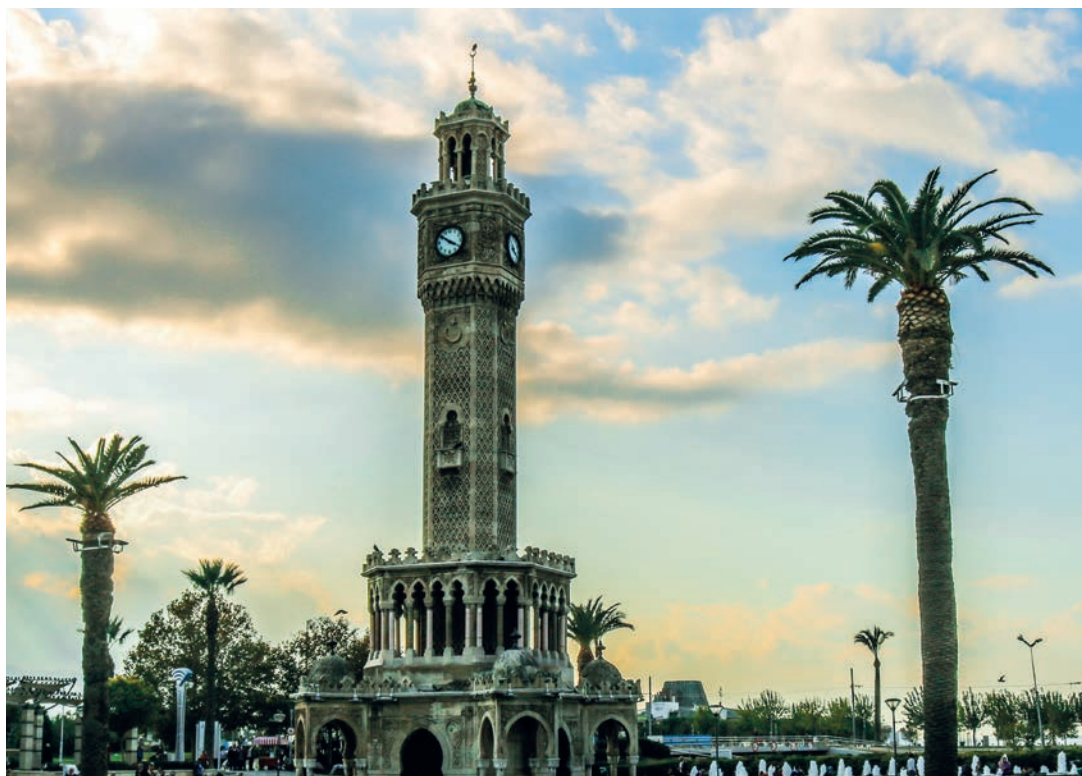
Det gamle klokketårn i Izmir blev bygget i 1901 for at markere 25-året for sultan Abdul Hamid 2's bestigelse af tronen. Klokken var en gave fra kejser Wilhelm 2. af Tyskland. Alliancen med Tyskland blev skæbnesvanger for Osmanneriget
