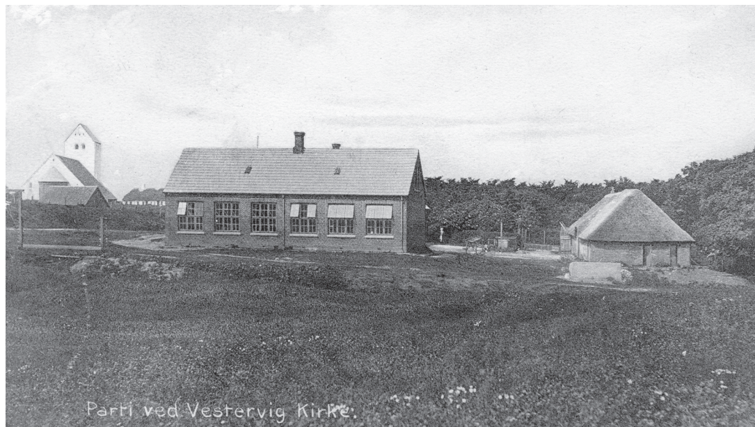
Parti fra Tygstrup, med Lindahlsminde skole. Der har langt tilbage været skole ved Vestervig Kirke. Det er kendt, at i 1815 opførtes en skole. Den blev afløst af disse bygninger i 1900, og der blev ansat en 2. lærer. I 1937 blev der oprettet en stilling som forskolelærerinde.
