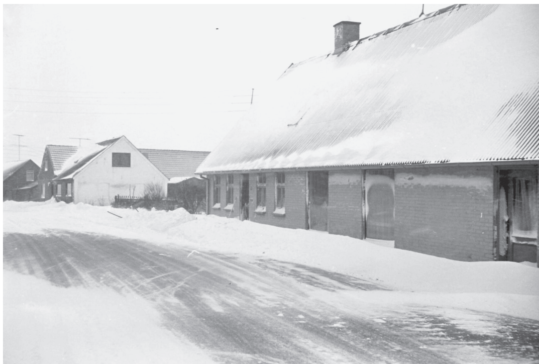
Den nedlagte gamle købmandsforretning i Gl. Bedsted vinteren 1978/79
