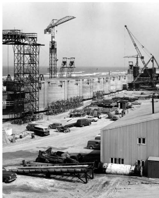
Hanstholm Havn under bygning. Betonstøbte sænkekasser. Ca. 1963.
