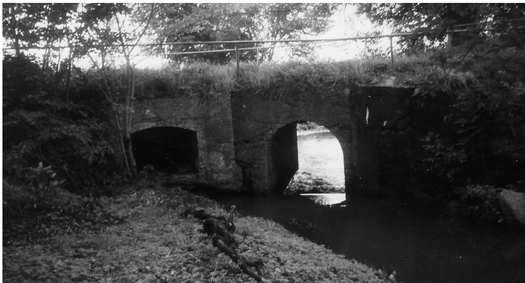
Vejbroen ved »Møllen« set fra haven. Den gl. mølle lå på den anden side af vejen. Underløbet til højre var normalt delvis lukket, hvorved vandet blev ledt ind i løbet til venstre. Foto: ETA 2002.
