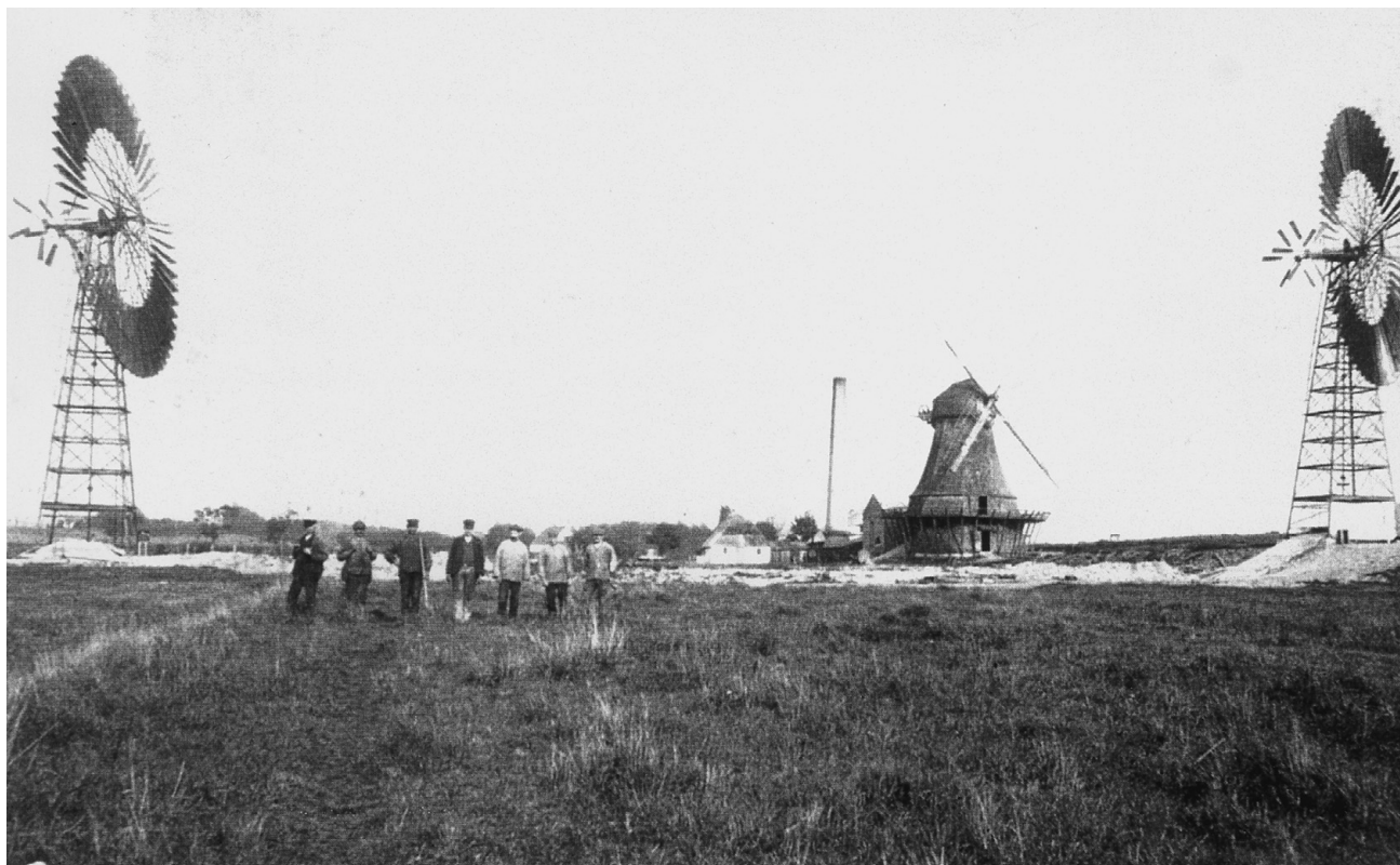
2 vindroser fra Hurup Jærnstøberi opstillet ved Lammefjord.
