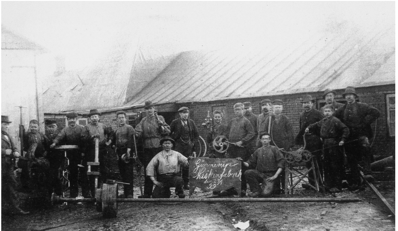
Ginnerup Maskinfabrik. T.v. ejeren Poul Jeppesen, t.h. vindmotor-montør Karl Klausen (senere Klausens Maskinfabrik). Fra venstre: Aksel til halmpakker, vindmotor, stabilisator til petroleumsmotor (holdes af dreng over skilt), længst til højre bukkemaskine, længst til venstre aksel til vindmotor.
