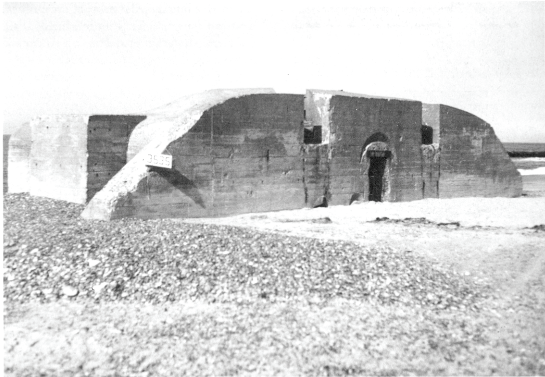
Bunker til 5-cm kampvognskanon, set fra sydøst. Indgang til bunkeren i midten mellem opgangene til kanonpladsen.
