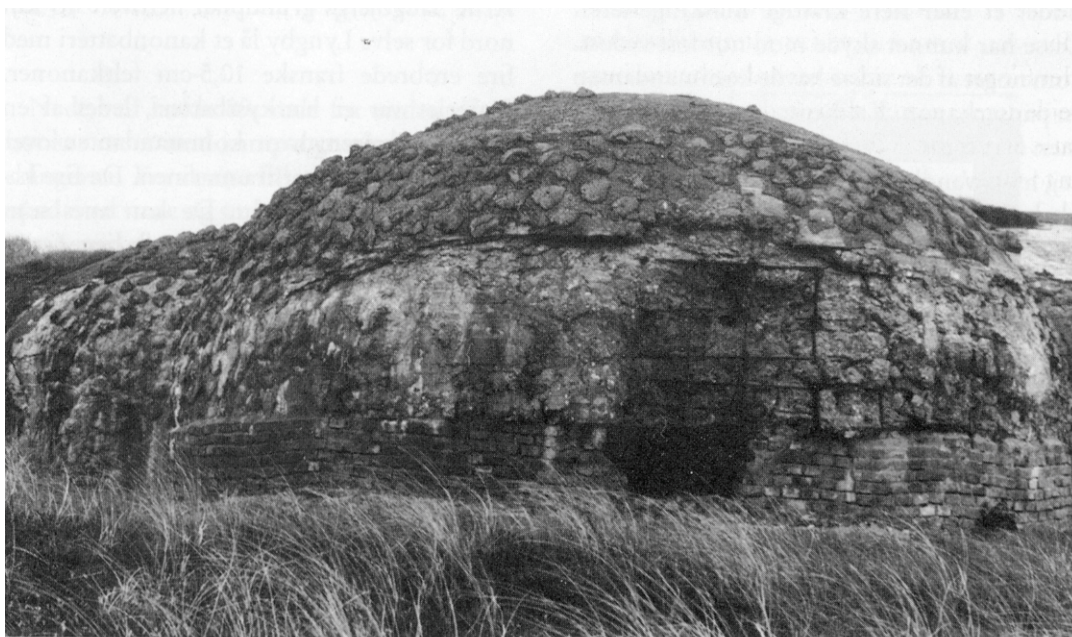
Kommandobunkeren i Lyngby-batteriet, set fra vest. Efter krigen har man skæmmet bunkeren ved at udfylde alle åbninger med mursten. Disse er senere delvis nedbrudte som her ved spalten til observationsrummet. Herinde var afstandsmåleren monteret.
