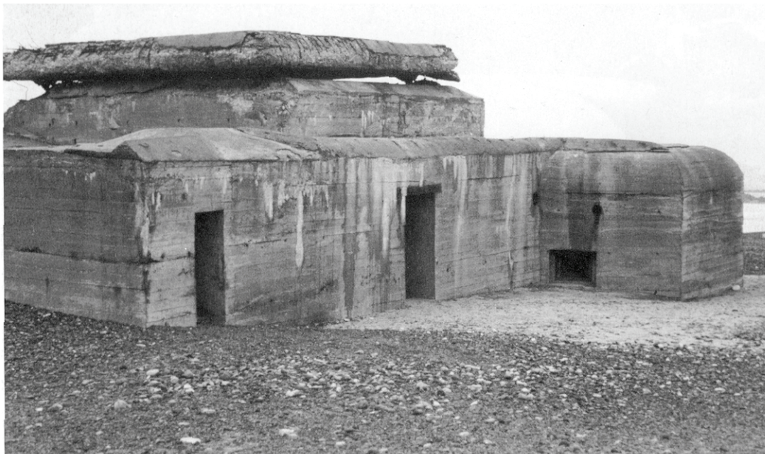
»Ildlederen på Agger Tange, set fra sydøst. Øverst en overdækket platform. Nederst til venstre opgang til obs.posten. I midten indgang til bunkeren. Til højre ses nærkamprummets åbning.
