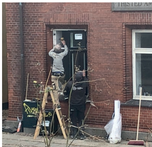
Der skiftes vinduer på det nye Thisted Museum, Jernbanegade i Thisted.
