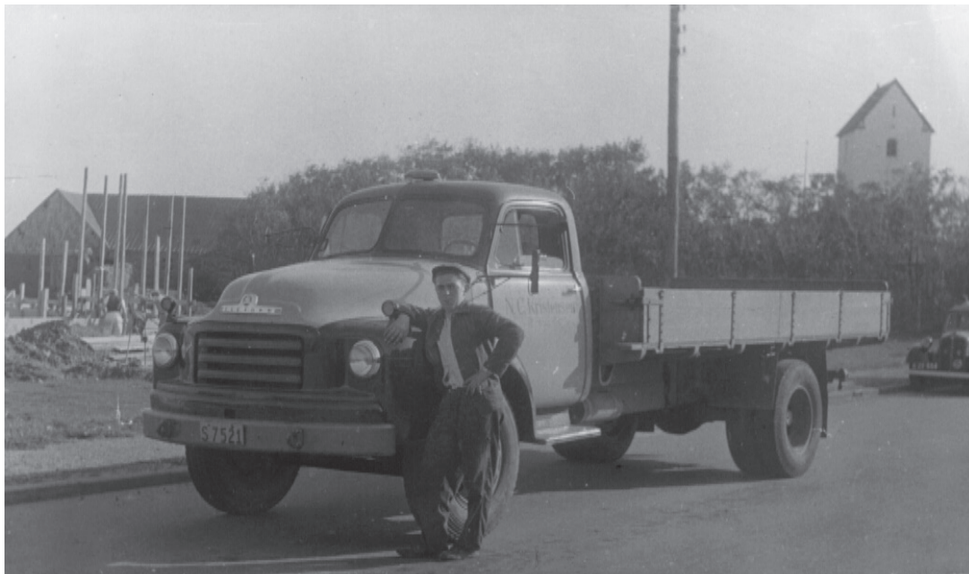
Ove ved Bedford foran byggepladsen ved Gettrup Alderdomshjem 1958. Privatfoto.
