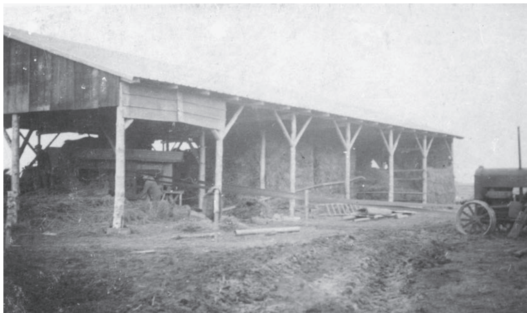
Thy Højspændingsværks lagerbygning fungerede oprindeligt som lade i Lodbjerg Plantage (Lortpøt). Den blev nedtaget, solgt, og opført på Værket hvor den i første omgang fungerede som tørrelade for tørv, senere som garage for vognparken, samt som lagerbygning.
