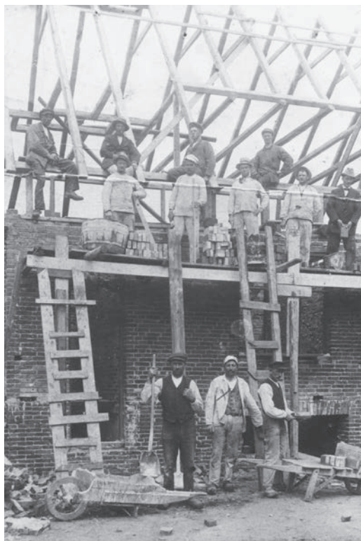
Ukendt håndværkersjak under opførelse af administrationsbygningen i 1918.
