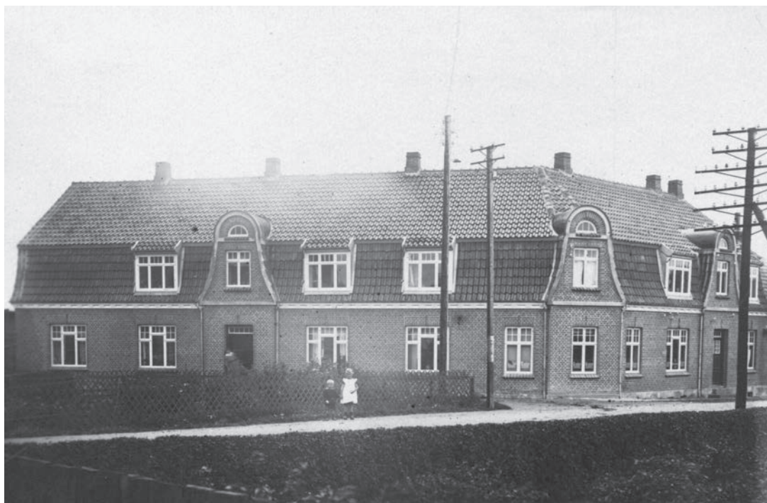
Thy Højspændingsværks funktionær- og administrationsbygning, bygget i 1918 for 35.580 kr. Der var fire funktionærljigheder samt diverse kontorer, alt opvarmet med varmt kølevand fra Værkets maskiner.
