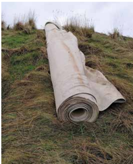
Den nye membran lignede et stort industri- gulvtæppe da det ankom til højen.
