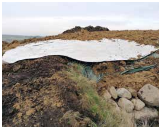
Udsnit af den nye membran der er lagt henover Lundevej. Ved sammenføjningerne er et stort overlap for at hindre vandet i at komme ned i gravkammeret. Foto Lars Bjarke Christensen/ Slots- og Kulturstyrelsen.
