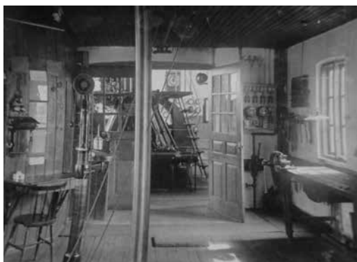
Thy Højspændingsværks ældste værksted, som det omtrent så ud da jeg blev ansat. I mange år var der kun én enkelt telefon til deling mellem drifts- og linjeafdelingen. Den ses på væggen over stolen.
