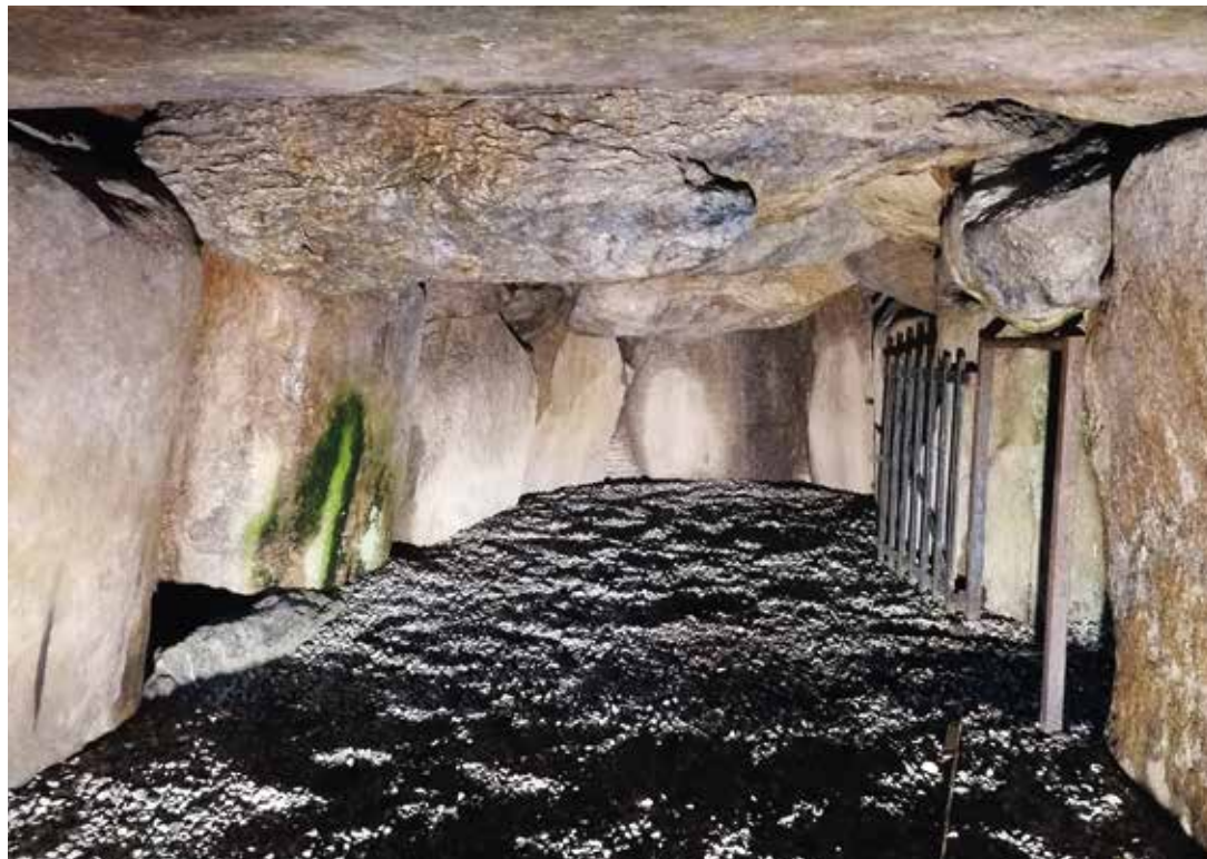
Jættestuens gravkammer. I forgrunden ses fragmentet af loftstenen (dækstenen) som var i fare for at styrte ned i gravkammeret. Foto Lars Bjarke Christensen/Slots- og Kulturstyrelsen.
