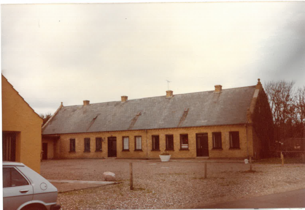
Stuehuset paa matr. nr. 34a i 1982.
