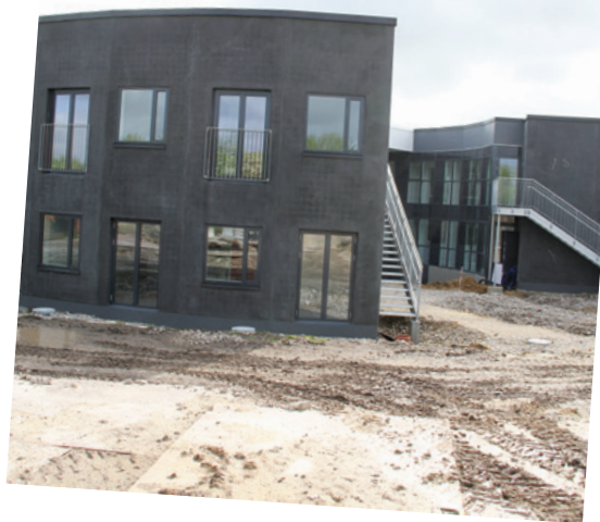
Håndværkere arbejder på højtryk for at gøre Rotunden klar til indflytning.
