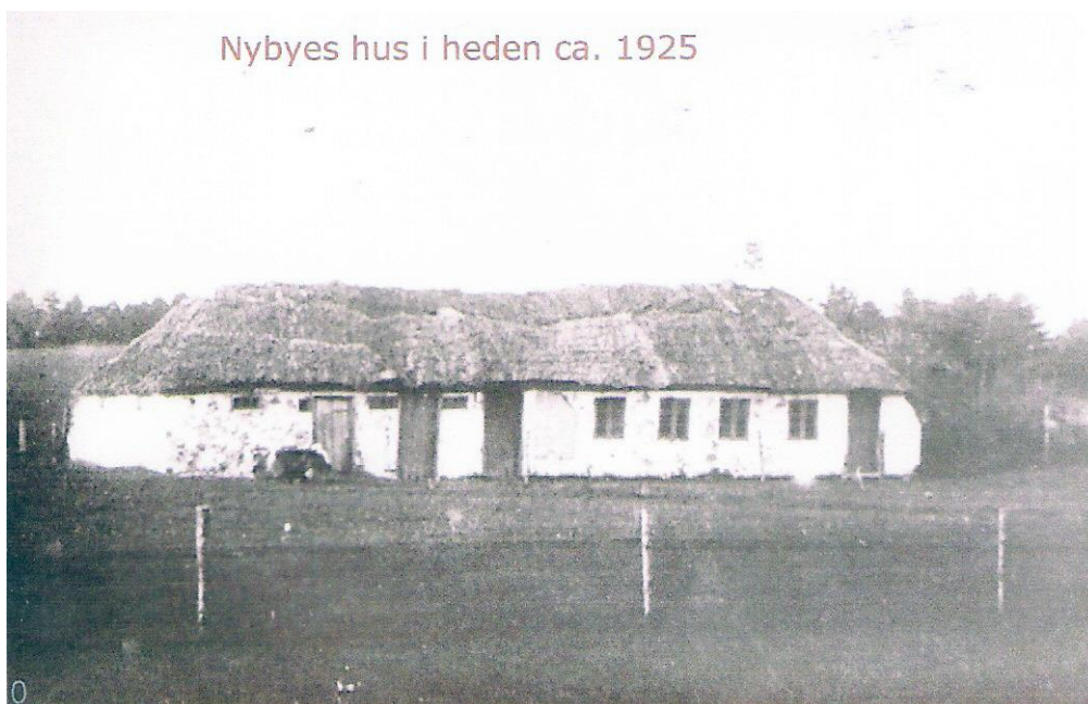
Niels Mathias Jensen Nybyes hus i Kallerup, det er revet ned i 1929.
