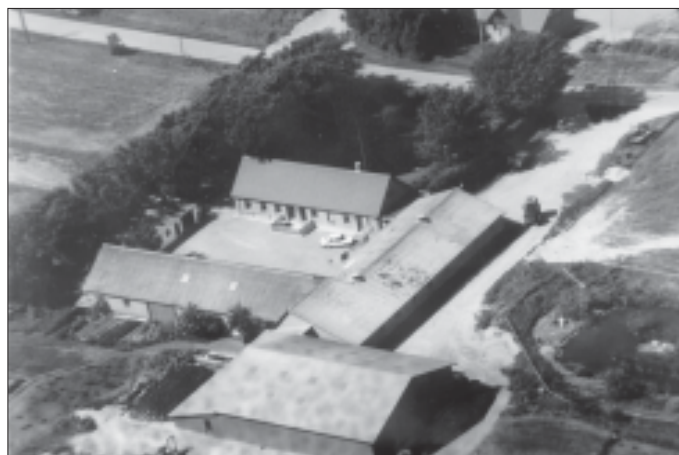
37c. Poul Overgård, "Munkholm", Brundvej 6. Ca. 1985.
