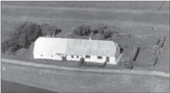
54b. Inger Madsens hus, Østerengvej 2. Ca. 1947.
