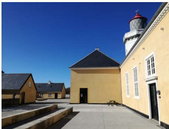
Fyrkomplekset, som det fremstår i dag efter endt renovering.
