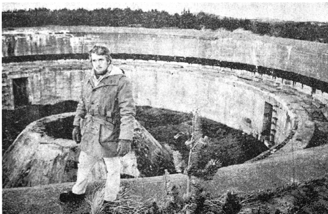
Lejrscoleleder Per Skanderby stående på kanten af kanonbrønden til den senere museumsbunker. Vendsyssel Tidende 12.12.1971.
