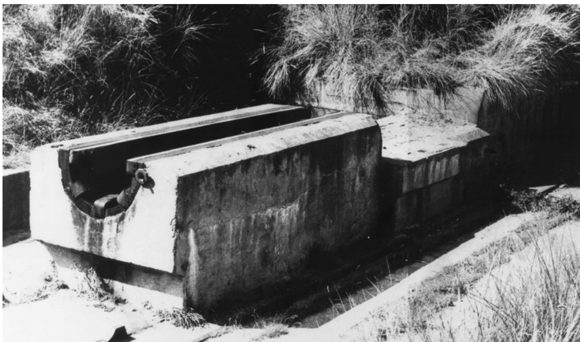
Ladeøvelsesapparatets betondele fotograferet ca. 1975. Fundamentet stod indtil 1994, hvor det blev fjernet for at give plads til aflæsning ved indkørslen til bunkeren, som anvendes som depot af Hjemmeværnet. (Bunkermuseum Hanstholm, Per Vesterager)
