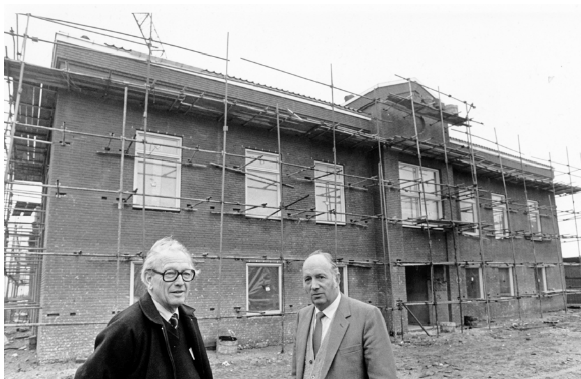
Så har Hanstholm Kommune endelig udsigt til at få et rigtigt rådhus, hvor alle forvaltningens 60 medarbejdere kan samles under ét tag. Ved rejsegildet i oktober 1986 ses til venstre rådhusets arkitekt, kgl. bygningsinspektør Jacob Blegvad. Til højre borgmester Verner Gregersen.
