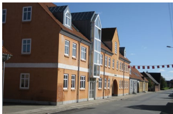
Boligkomplekset Harepark, der blev opført i 1993.
