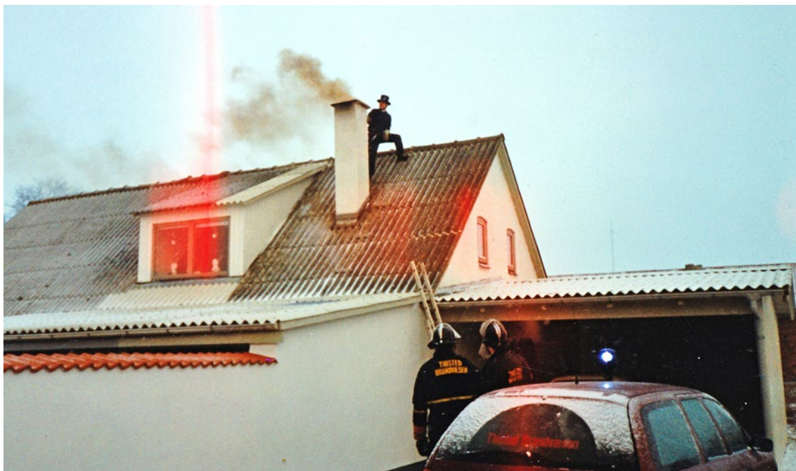
Skorstensfejning er nødvendig for at undgå skorstensbrand. Her er det alligevel gået galt i 1996 på Lerpyttervej 23 ved Thisted.
