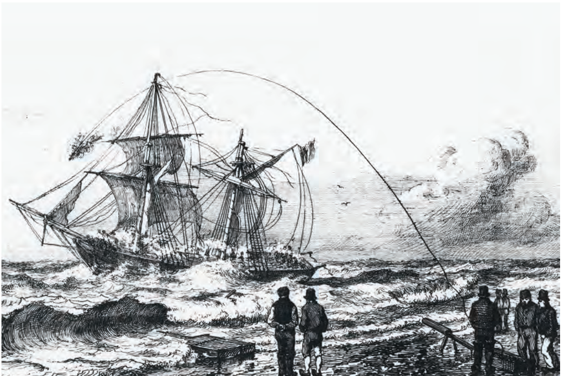
Et eksempel på en redningsaktion. Med raketapparatet skydes linen ud over skibet, hvorefter besætningen kan hales i land med redningsstolen.
