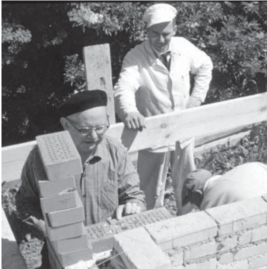
Far lægger mønster ved grundstenen. Murermester Hebsgaard kigger til. 1962.
