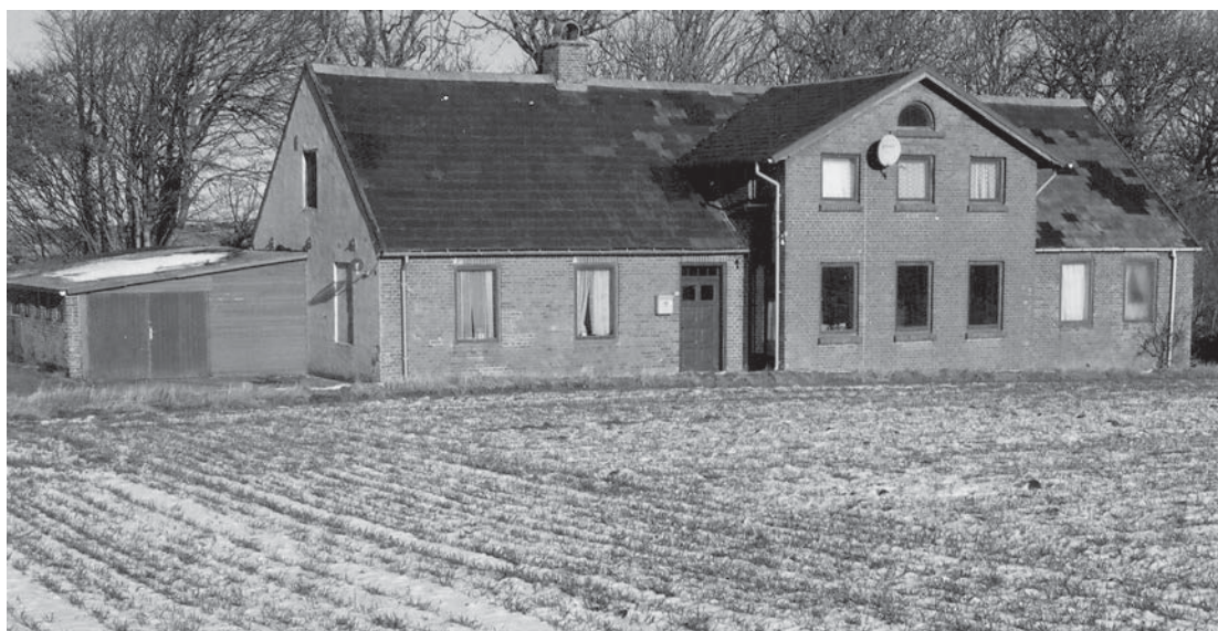
Gærup skole står foran nedrivning. Her er den fotograferet i februar 2009 af Liv Stange. Hun har sammen med Aksel Kristensen målt skolen op og tegnet en grundplan til museets arkiv.
