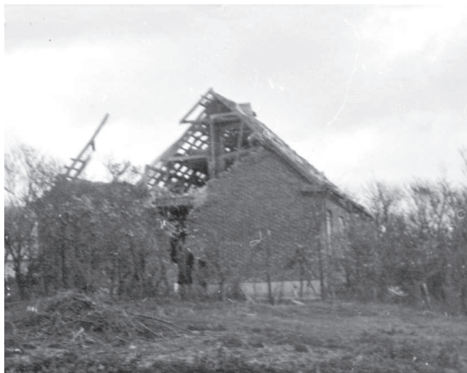
Den beskadigede vestgavl på »Vestergård« stuehus. (Foto: Johannes Thomsen via Ib Nielsen)
