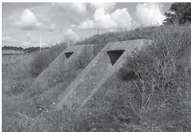
Den lille beskyttelsesbunker, som i dag er den mest synlige del af skinanlægget. (Museumscenter Hanstholm).
