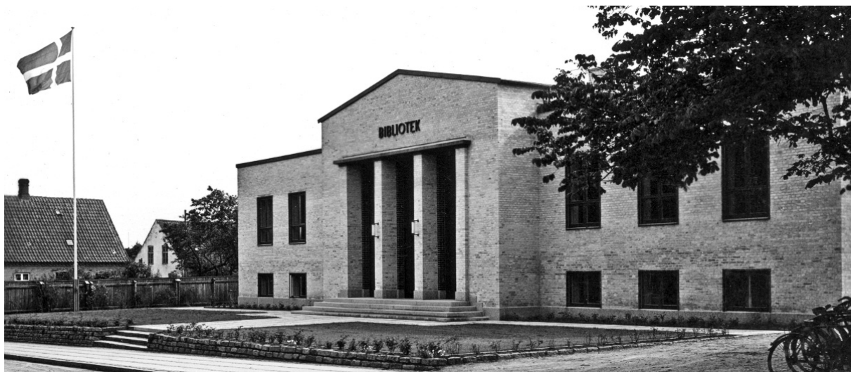
Thisted Bibliotek umiddelbart efter opførelsen i 1938.
