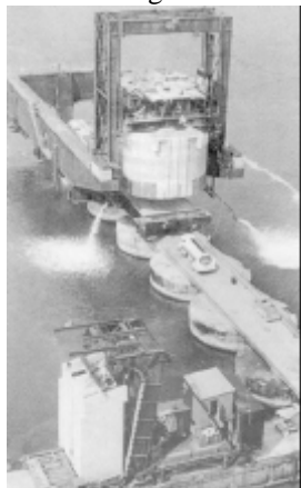
Den specialbyggede skotske kran, der satte betonkasserne på plads på havbunden. Kranen vejede 600 tons.
