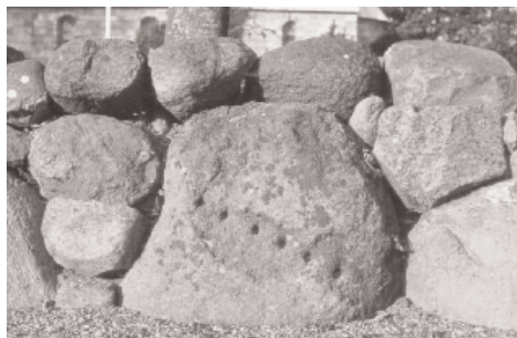
Mislykket kvader: I kirkediget i Stagstrup sidder denne sten, som stenhuggeren har opgivet at få en kvader ud af. Han har hugget alle kilehullerne ned over fladen og har så alligevel kasseret den.
