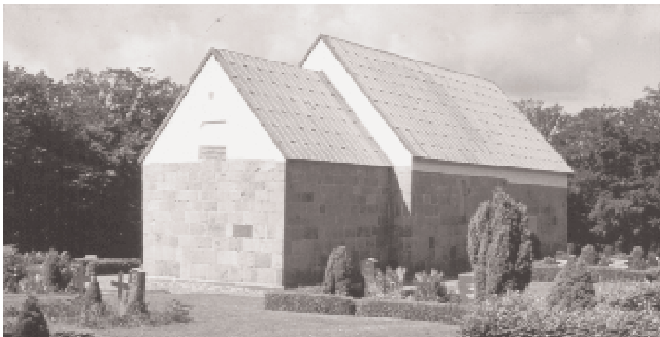
Romansk kirke: Øster Vandet Kirke ser i dag ud, som de allerfleste af Thys kirker må have set ud lige efter opførelsen, med kvadersat skib og kor og med bly på taget. Oprindeligt må kvadrene have været ført helt op i gavlspidsen, men de er ved de omsætninger, der har fundet sted, blevet erstattet med tegl. Selv om vi i dag opfatter kirken som en forholdsvis beskedne bygning, må den på byggetidspunktet have været meget stærkt dominerende i landskabet.
