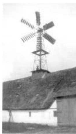
Møllen på Ulstrup. Den opsattes i 1920 og forsynede gården med elektricitet helt frem til 1953. Den var tillige trækraft for roeskæring, vandpumpning, valsning af korn og formaling af korn. De første år trak den også tærskværket.
