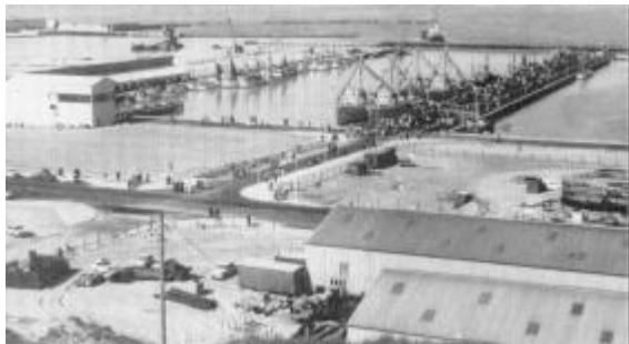
Hanstholm Havn ved indvielsen i 1967 en kæmpemæssig byggeplads, en halvfærdig havn. (Foto: Jens Steffensen).
