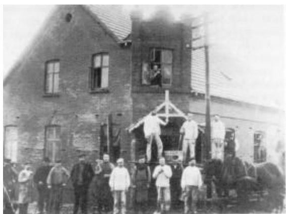
Hundborg Apotek under opførelse.
