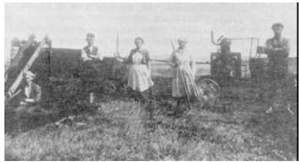
Tørvearbejde i Hundborg mose ca. 1925. Til højre en petroleumsmotor, til venstre æltemaskinen.
