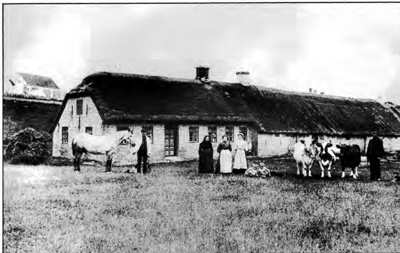
Typisk thylandsk husmandssted fotograferet i Røbr 1908. Stald med udskud i den ene ende og stuehus i den anden.
