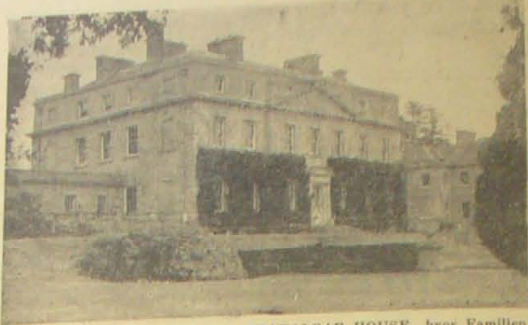
LORD NELSONS HERRESÆDE, TRAFALGAR HOUSE, hvor Familien Nelson har boet siden Slaget ved Trafalgar, er nu overtaget af den engelske Stal, der har indrettet det til Brug for Marinen.
