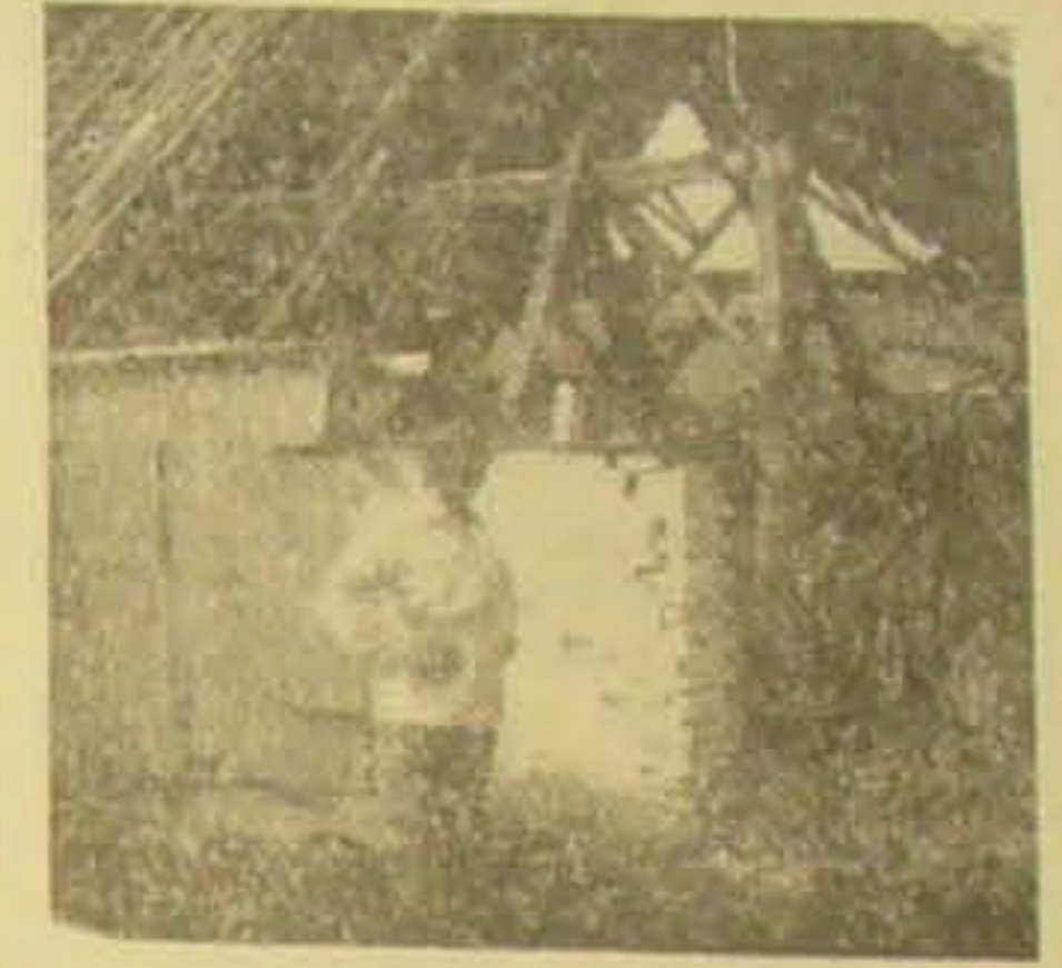
En af de Gaarde, som blev pustet om ved den frygtelige Eksplosion den 26. September i Fjor. Her maa bygges op paany helt fra Grunden.
