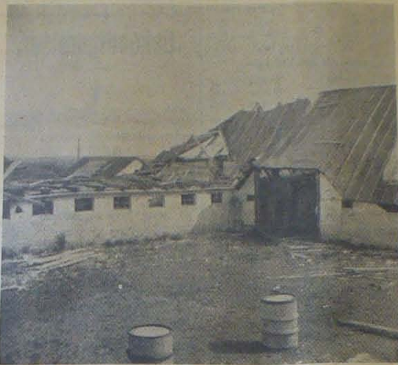
Saaledes ser „Skolegaard“ ud i Dag. Udbygningerne er i den Grad ødelagt efter Mineekspllosionen ved „Gl. Lines Hus“, saa de nu maa rives ned.
