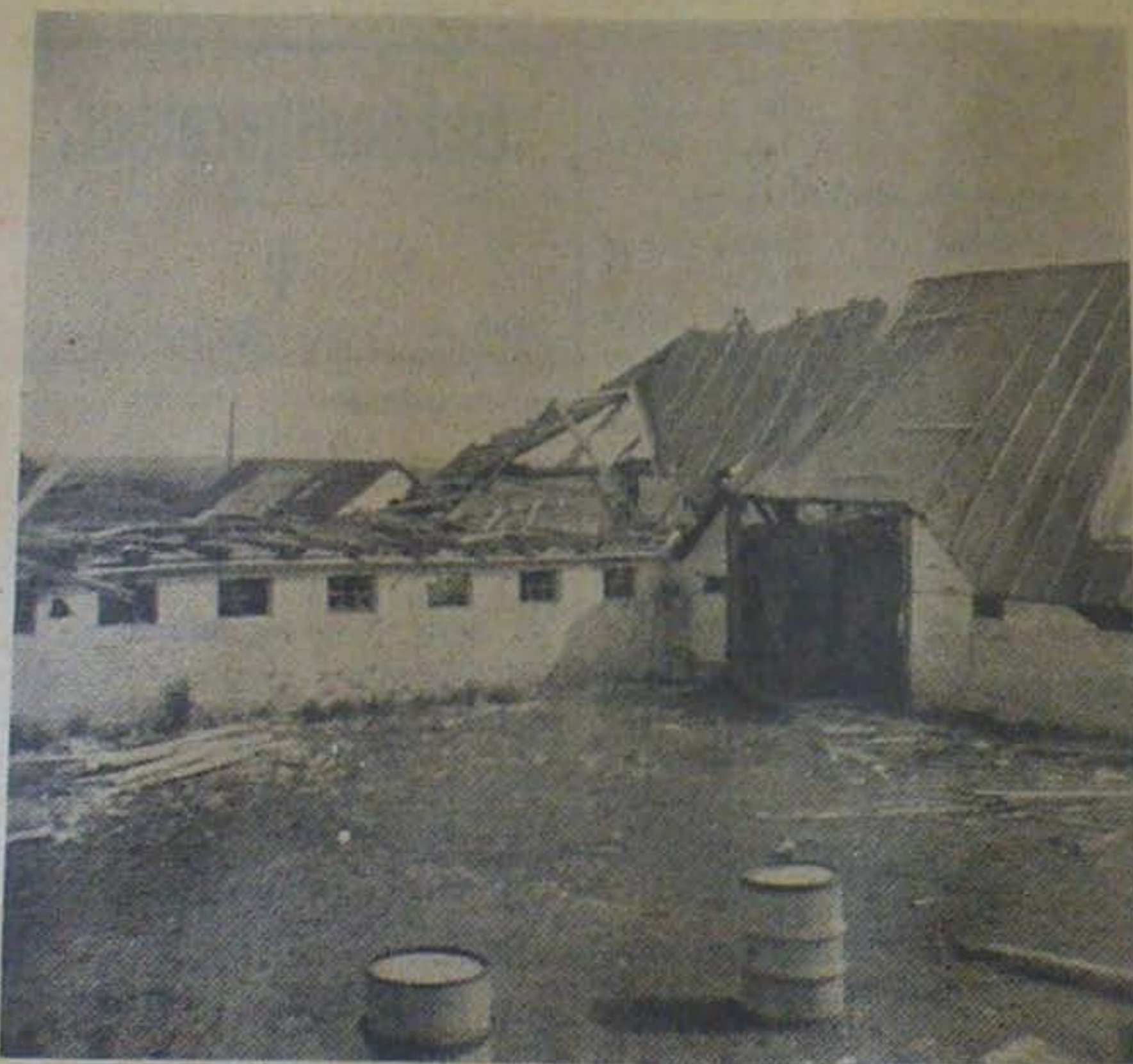
Saaledes ser „Baadsgaard“ ud i Dag. Udbygningerne er i den Grad ødelagt efter Mineeksplosionen ved „Gl. Lines Hus“, saa de nu maa rives ned.
