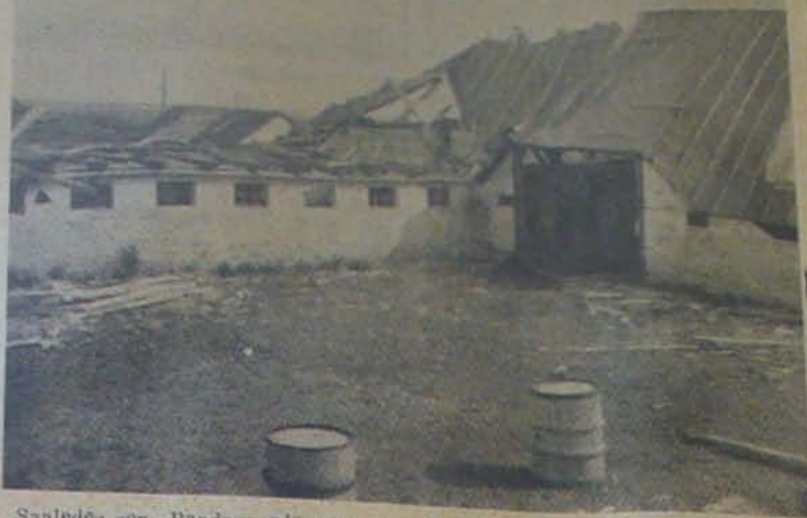
Saaledes ser „Baadsgaard“ ud i Dag. Udbygningerne er i den Grad ødelagt efter Mineekspllosionen ved „Gl. Lines Hus“, saa de nu maa rives ned.
