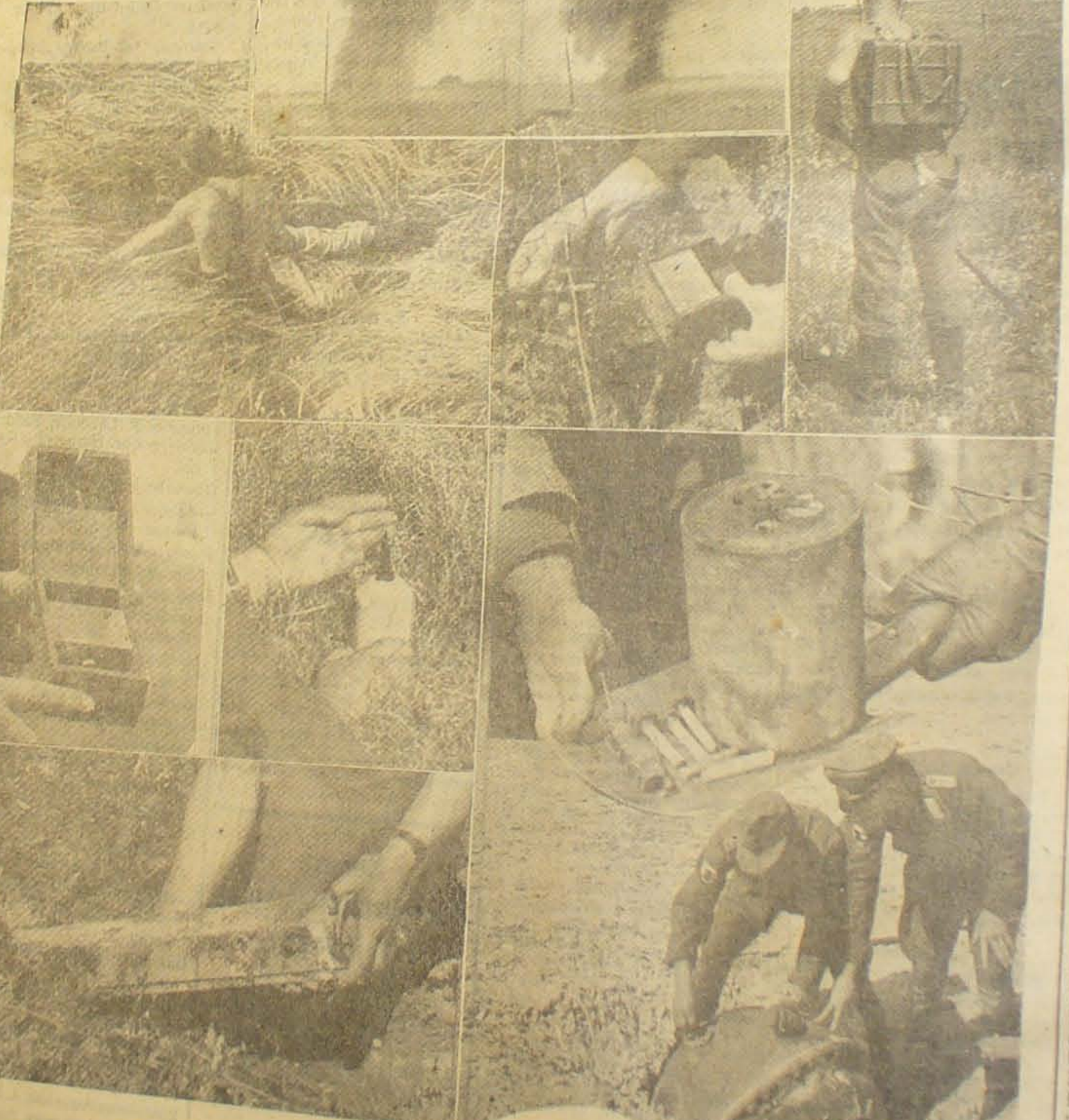
Overet ses to Pansermine Eksplosion. — I anden Række ses fra venstre: To tyske Pionerer, der roder efter S-Miner i Klitten, derefter: En af de mindste Fodfolksminer bliver taget op. Den ser ud som en Kasse med 50 Cerutter! Bemærk Snoren, der gaar over Soldatens Haand og Mærket, der sidder paa denne Snor. Efter Kortet over Minefeltet udsendes saadanne smaa og under hvert Mærke skal, saafremt Nedlægningen er udført omhyggeligt, findes en Mine. Til højre: Der lyttes efter Miner. — I tredje Række ses først den foran omtalte Cigarkasse. Denne Mines Virkning siger at være bedst — der gaar et Ben, maaske en Fod eller to. I næste Fald får man Underlivet revet op. En anden vil jo synes, at dette er mere end almindelig Spade. Tændret og Tændstæ ses foran. Denne anbringes med et Par Tommer Jord over. Træder man saa paa den, sker der først en lille Eksplosion, hvorefter hele Beholderen, der ser ud som et Littermaal, farer 1½ Meter op i Luften, hvorefter sker den egentlige Eksplosion. Beholderen indeholder bl. a. 300 smaa, skarpe Jernstykker (se Billedet andet Steds af Støvminen), og disse farer med frygtelig Kraft vandt gennem Luften i en Afstand paa mindst 50, højst 200 Meter fra Eksplosionsstedet. — I nederste Række bliver en Pansermine, R-Mine, taget op. Det er en lang Trækasse, der indeholder 6 kg. Sprængstof. Dennes Virkning ses paa ovennævnte Billedet. Endelig et Billedet fra Fotostuden. En rigtig Pansermine er halv begravet i Sandet, og to Tyskere piler ved den. Den var afmonteret af de Følgende.
