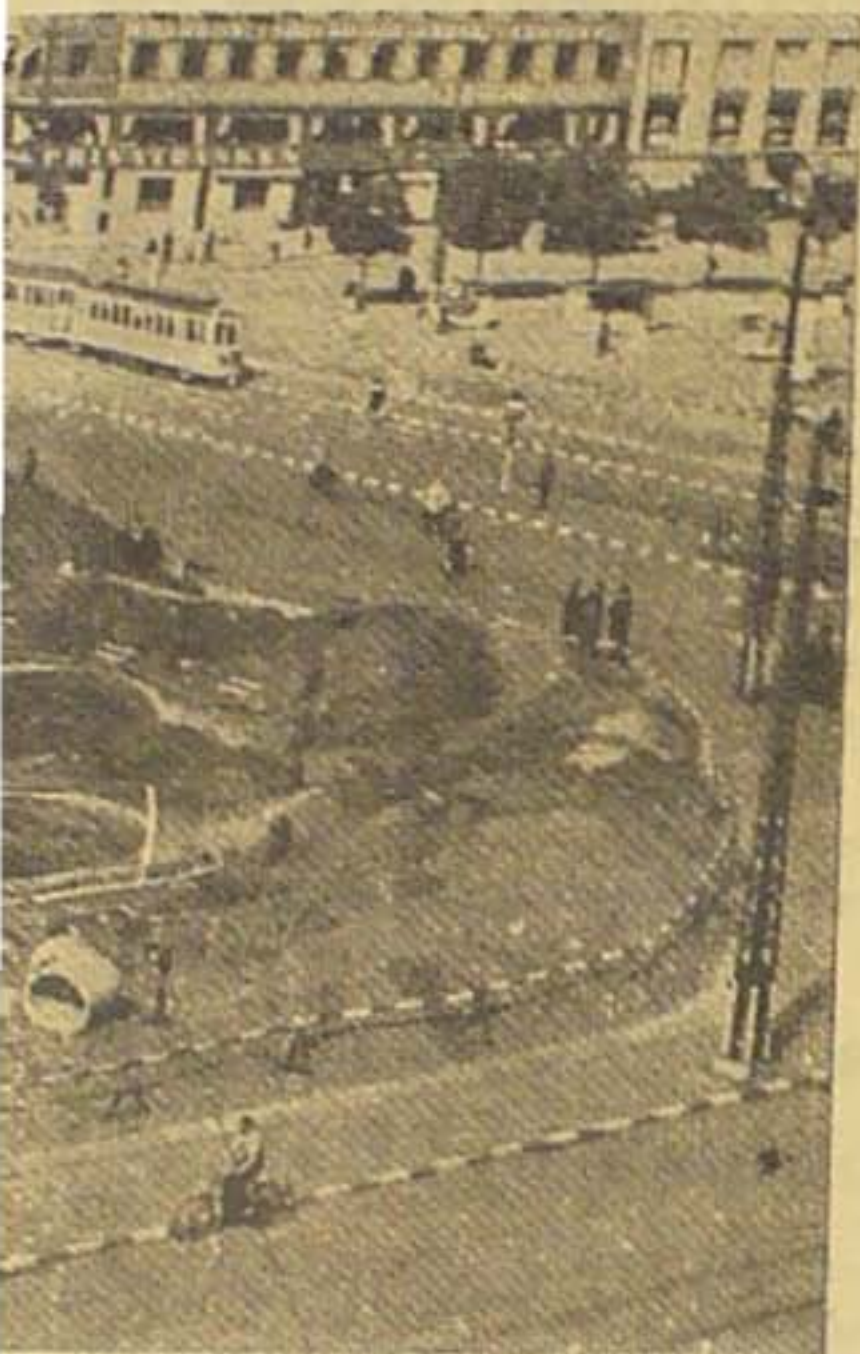
Støbningen af de mange Bunkers vil være
