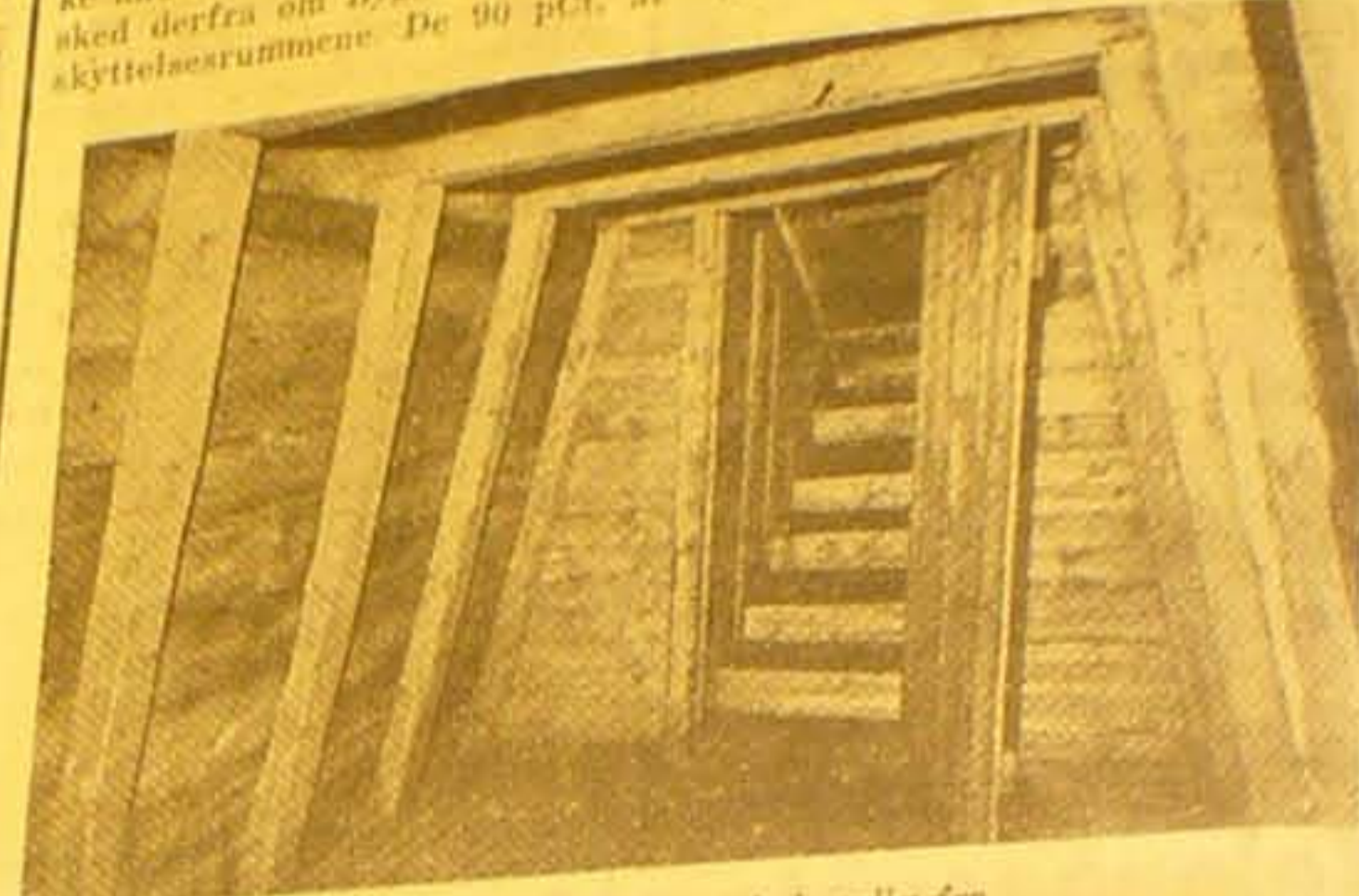
Beskyttelsesrummet set indvendig fra.
