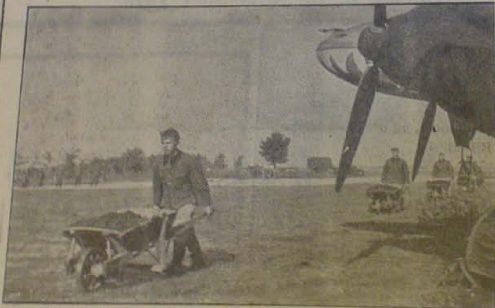
Arbejde med Anlæg af en Flyveplads.
