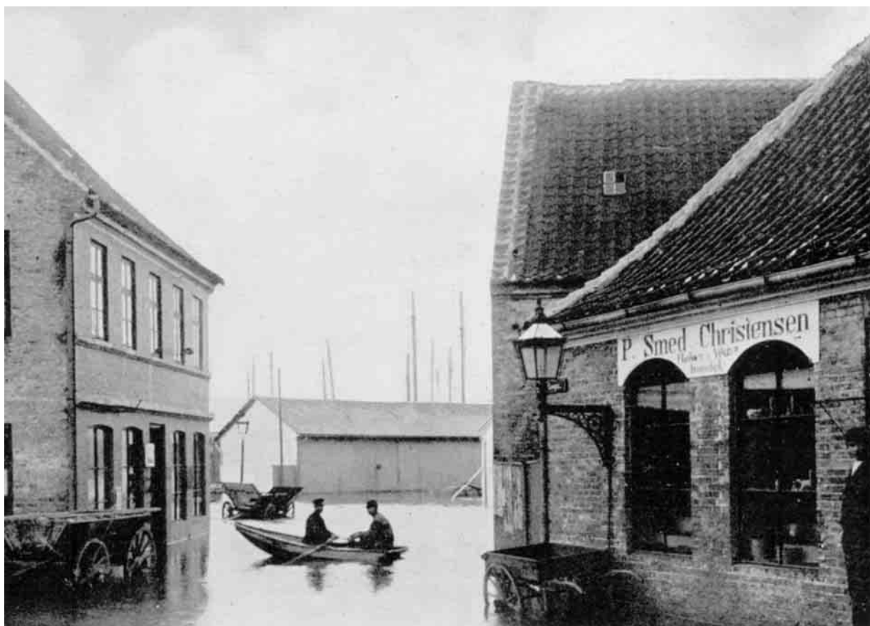
De laveste beliggende Bydele i Thisted var tidligere ved Tøbrud og Højvande udsat for stadige Oversvømmelser. En saadan Situation ses paa Billedet, der er taget paa Hjørnet af Korsgade og Storegade omkring Aarhundredeskiftet.
