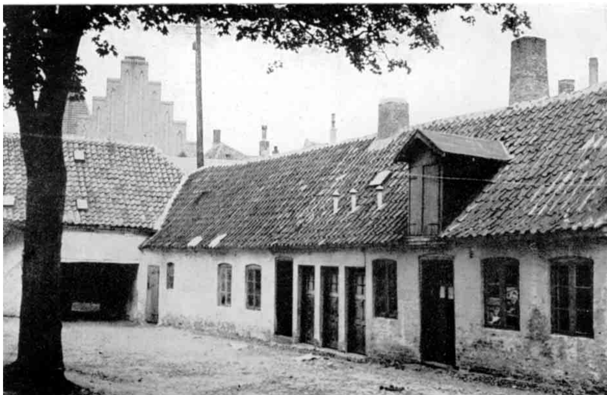
For 100 Aar siden havde Thisted intet andet Sygehus end en meget primitiv "Sygstouw" i denne lave Gaardlænge i Ejendommen Storegade 21 (C. P. Clausens Gaard). Byens første Sygehus opførtes i Halvtredserne og det nuværende i Aarene 1924-28. (A. Scharling fot.)
