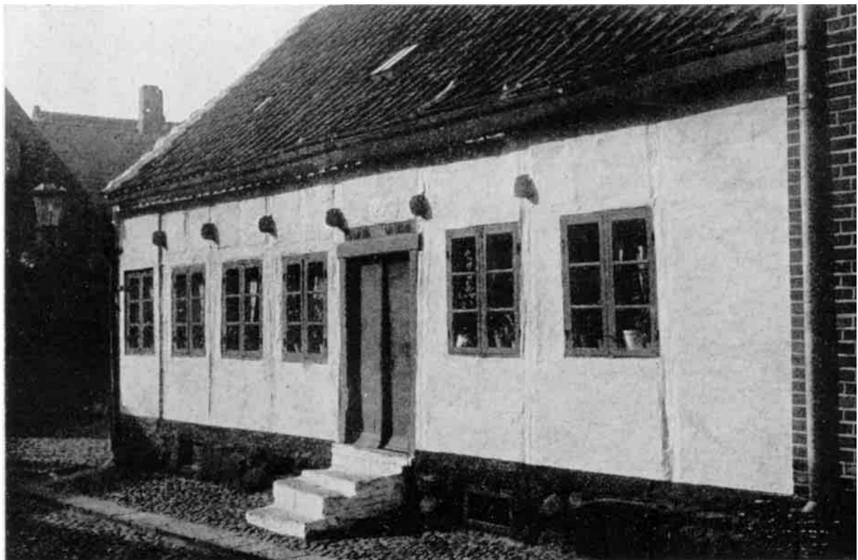
Skorstensfejermester Ahlbergs Hus i Strømgade i Thisted var en af Byens sidste Bindingsværksbygninger. Det blev 1915 nedbrudt, og Frelsens Hærs Bygning opførtes paa Grunden. (Fot. Thisted Musæum).
