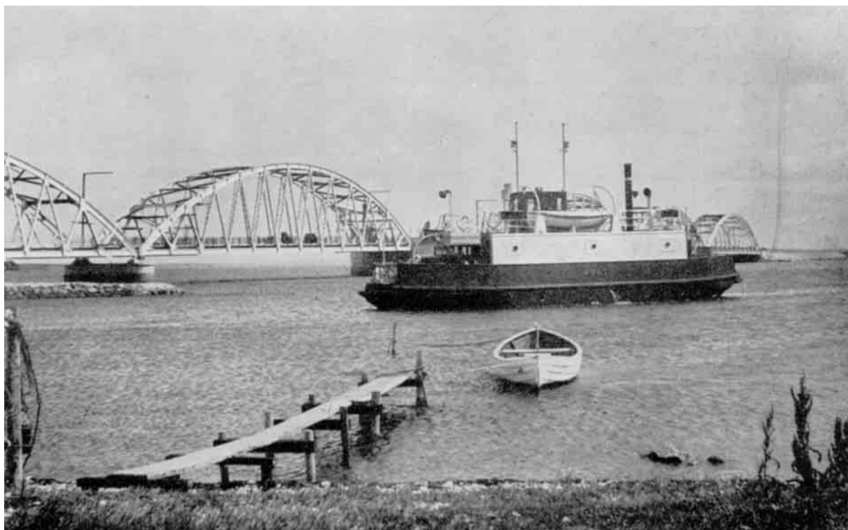
Efterhaanden afløstes Færgeprammene af Dampfærger, og vort Aarhundrede saa den moderne Teknik slaa Bro ved flere af de kendte Overfartssteder. Her sejler Vildsundfærgeren en af de sidste Ture før Broens Aabning i 1939. (Aage Pedersen fot.)
