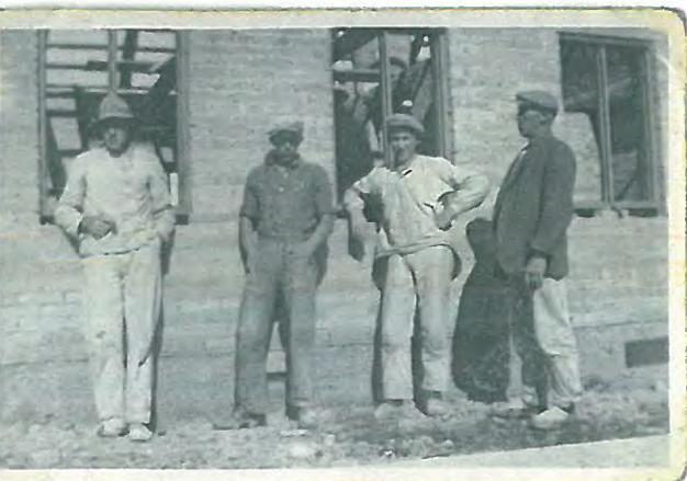
det nye hus under opførelse, murerne er fra venstre Chr. Christensen og broderen Thomas der var oppasser, samt mestersvend
