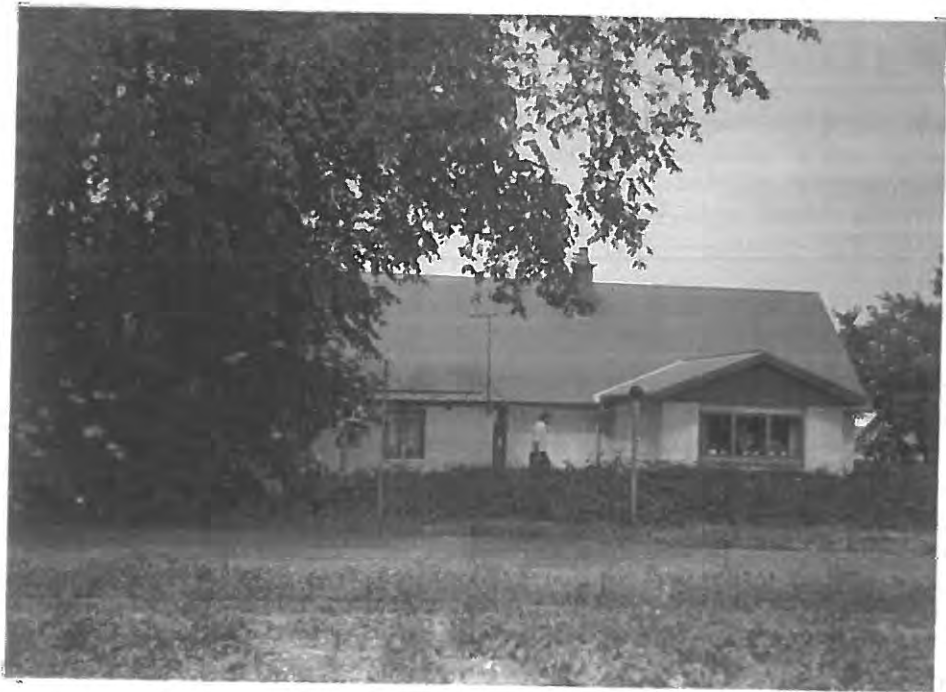
Og Sådan ser huset ud efter endt restaurering fra sydsiden ca.15 år senere.
