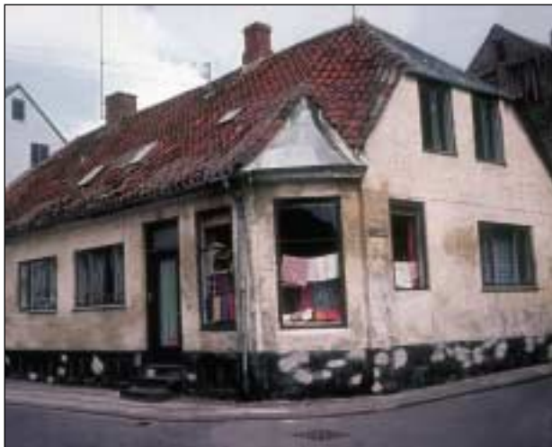
Beboelseshus i Nørregade 1971. Kan stå som et symbolsk udtryk for Thy i begyndelsen af 1970'erne, da egnen blev omtalt som både et "problemområde" og "en arbejdsløshedsø". Men forandringer var på vej. Og Nørregade-huset var et af dem, der blev omfattet af den store sanering af hele Nørregade-kvarteret, som senere bliver realiseret. Det var i øvrigt ikke så lidt af en kraftpræstation af Thisted Byråd at gennemføre denne sanering. Og for håndværkerne i kommunen en øget beskæftigelse.
