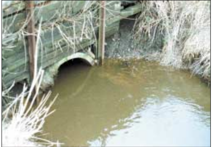
Kraftig forurening af å i Sperring med spildevandet fra mejeriet i Sjørring. 1983.
