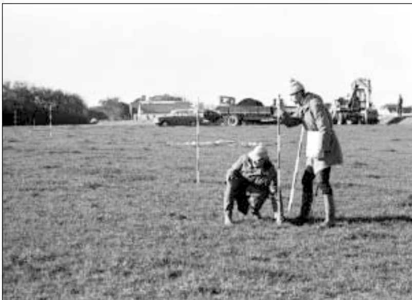
Oktober 1971. Landmålere er på arealet øst for Wilhelmsborg i færd med at afsætte grunden til A/S Hellesens nye fabrik.
