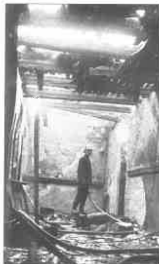
Da Realskolen gik op i flammer 1924. Der var sat vand over på to gasblus. Da de to rengøringskoner forlod skolen på Plantagevej om eftermiddagen, troede de, at skolebetjent Mortensen - der opholdt sig i gymnastiksalen - ville slukke for blussene. Men han forlod skolen kort efter i den tro, at rengøringskonerne gjorde det og lod derfor gassen brænde. Og skolen med ...
