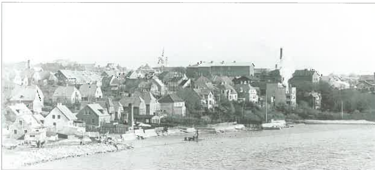
De første pæle bankes i til den nye vej langs kysten. Vejen blev bygget 1951-53.
