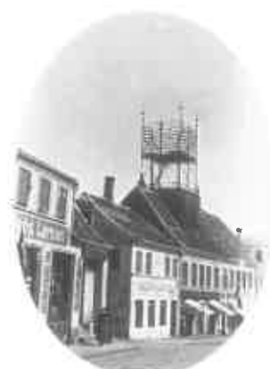
Tårnet på Thisted's første telefon- central på Store Torv. Herfra blev luftledningerne ført ud til abonnenterne. Tårnet blev først fjernet i 1920'erne. Centralen var allerede i 1908 flyttet til Drags- bækvej.
