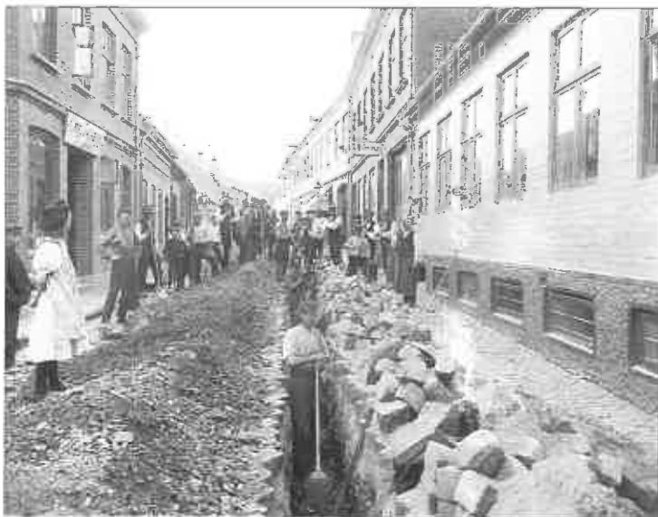
Gravearbejde i den nederste del af Storegade, der blev kloakeret i 1913.
