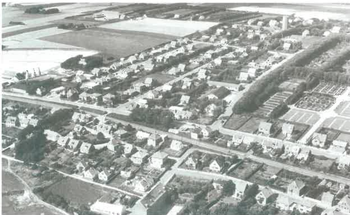
Kvarteret syd og nord for Hundborgvej i 1955. Hovedparten af husene er opført til to familier. Foto: Sylvest Jensen.
