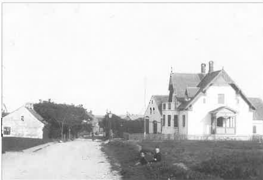
Møllevej ca. 1915 ned mod byen. Til højre Chr. Madsen "Jylland"s villa. Naboejendommen husede senere margarinefabrik, trykkeri, kirke og forretning.
