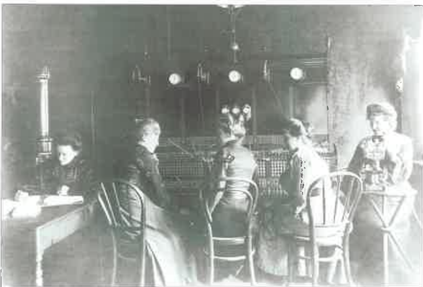
Thisted Telefoncentral i 1895. Centralen var indrettet i et lejet lokale på Hotel Royal ved Store Torv indtil 1908, hvorefter den blev flyttet til Dragsbækvej 32, som Jydsk Telefon havde købt. Her blev der i 1915 opført en ny centralbygning, som var i brug helt indtil automatiseringen i 1970.
