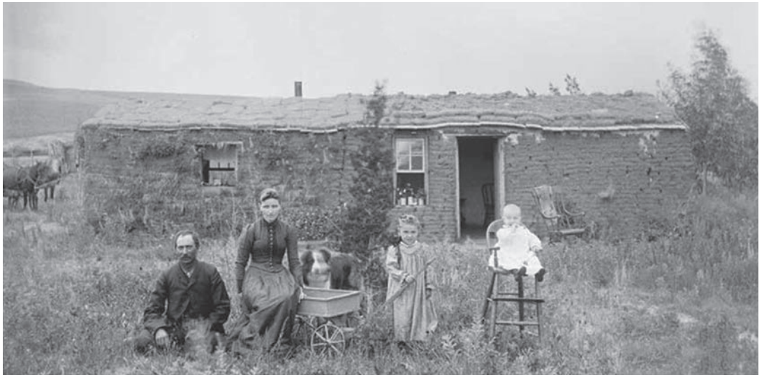
Et klassisk nybyggerhus. Nødtørfigt og billigt, bygget af tørv.
